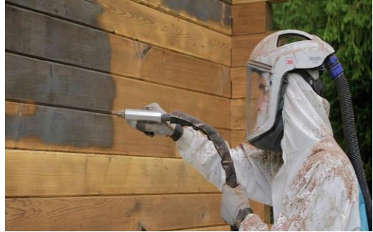
Figure 1 : Nettoyage d'une surface par aérogommage
