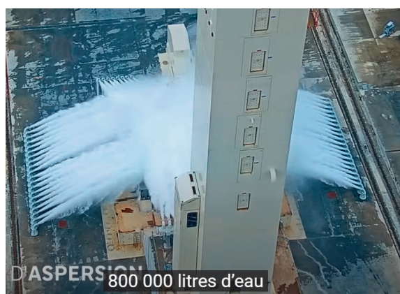
Figure 1. D'après une vidéo du CNES : Le système de déluge de la zone de lancement d'Ariane 6
