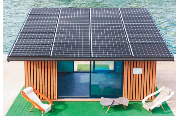
Figure 1. Panneaux photovoltaïques sur un toit plat
